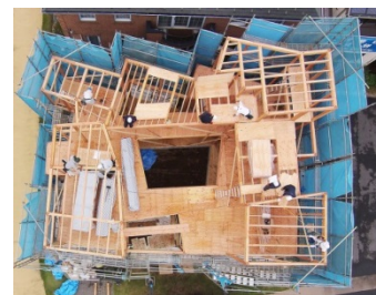
空から見た現場
