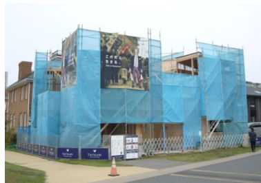
上棟した現場
