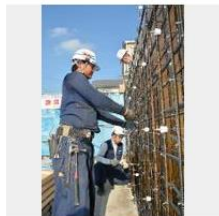
工藤建設が養成している多能工チームの3人。地下室築造後、化粧壁の作業に取り掛かった＝横浜市青葉区
