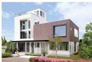
新築住宅の建築事業
